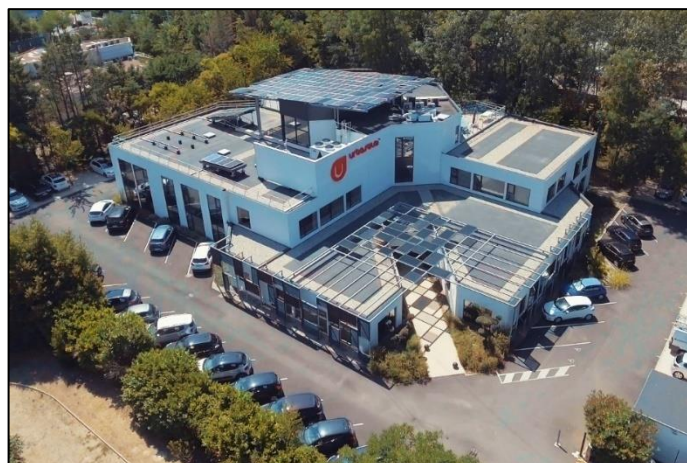
Locaux d'URBASOLAR Source : URBASOLAR
